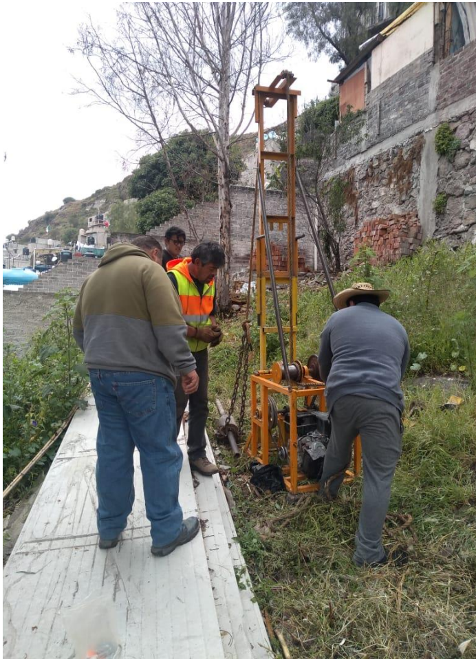
Trabajos en campo del Estudio de Mecánica de Suelos
