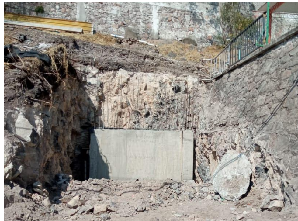
Muro de contención terminado
