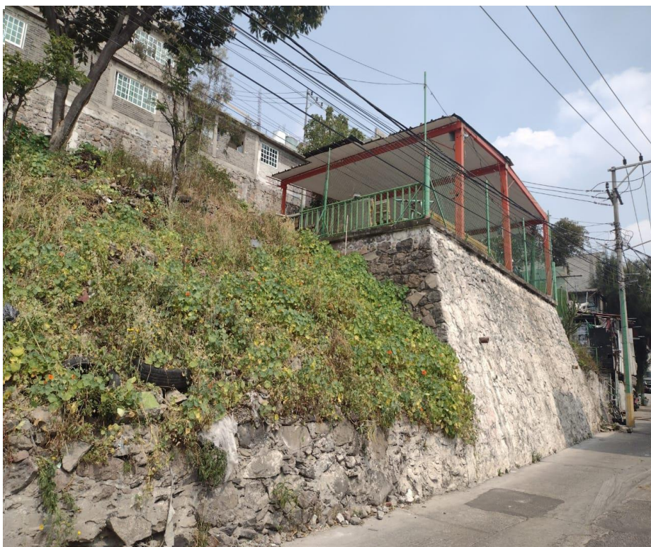
Estado original del sitio
